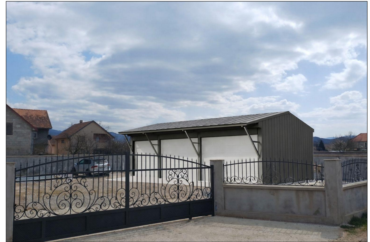
pogled sa ulice (sa sjeverozapada)
