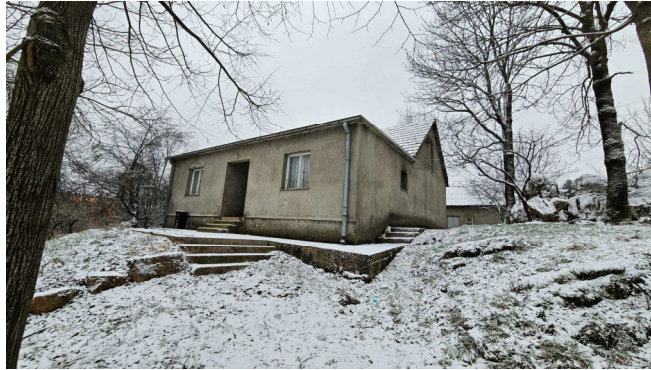
Slika 1: Pogled na postojeći stambeni objekat sa sjeveroistoka, koji je u istočnom dijelu na mjestu ulaza, dograđen betonskim blokom
