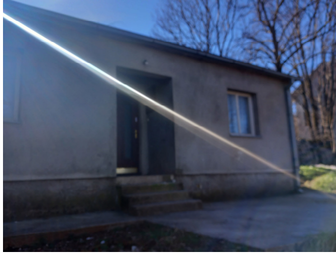
Slika 3: Pogled na zapadnu fasadu postojećeg stambenog objekta ulazni dio objekta
