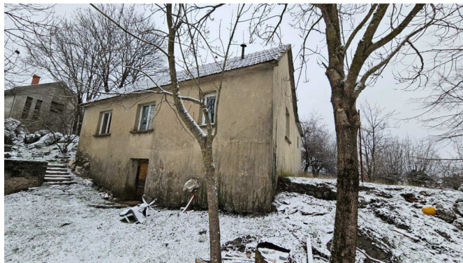
Slika 2: Pogled na postojeći stambeni objekat sa jugozapada, nakojem se vidi postojeći suteran, nad kojim je izvršena nadgradnja stambenog objekta
