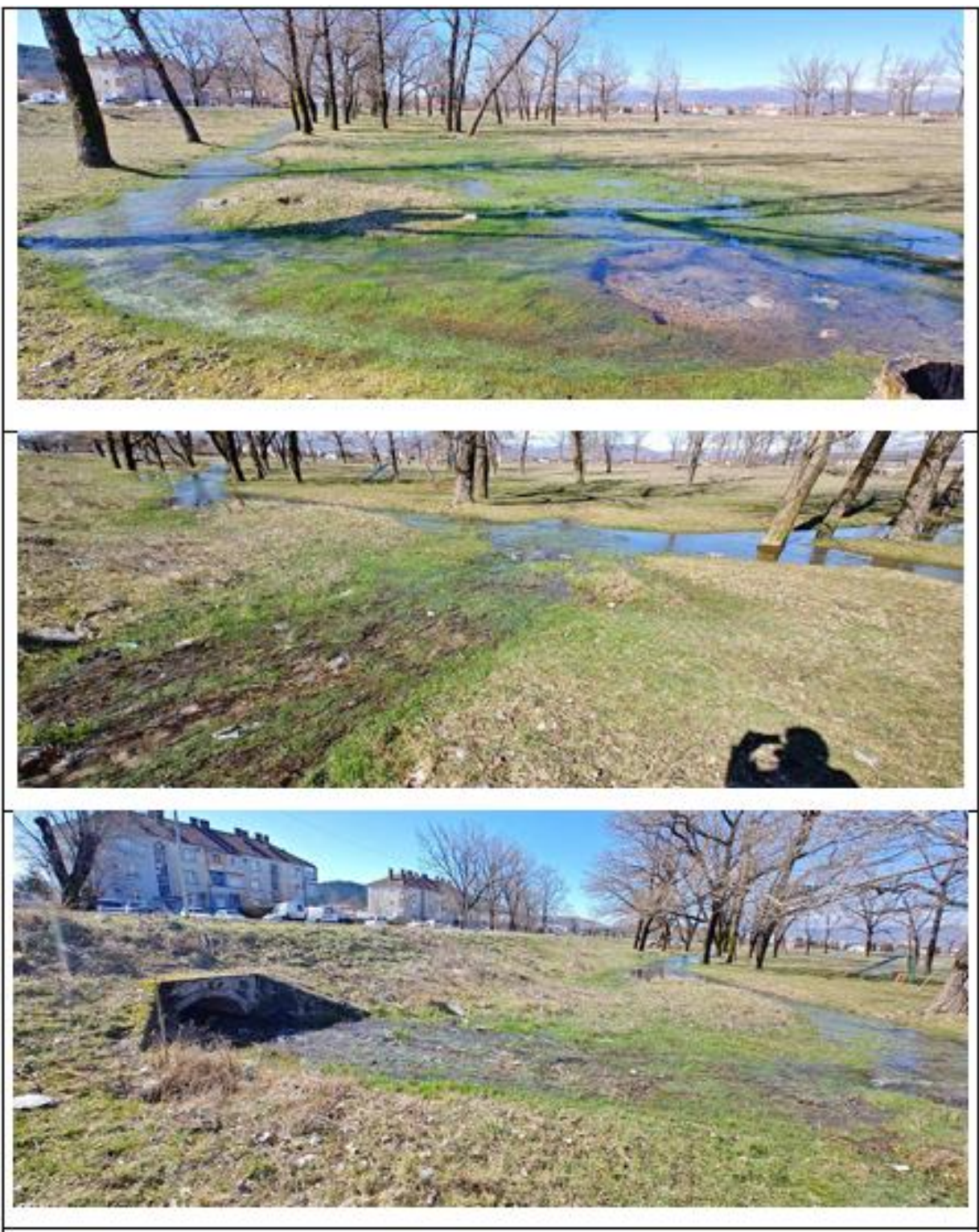
Sl. 2.14. Zona protoka 5 (zapadna strana-na malom mostu)
