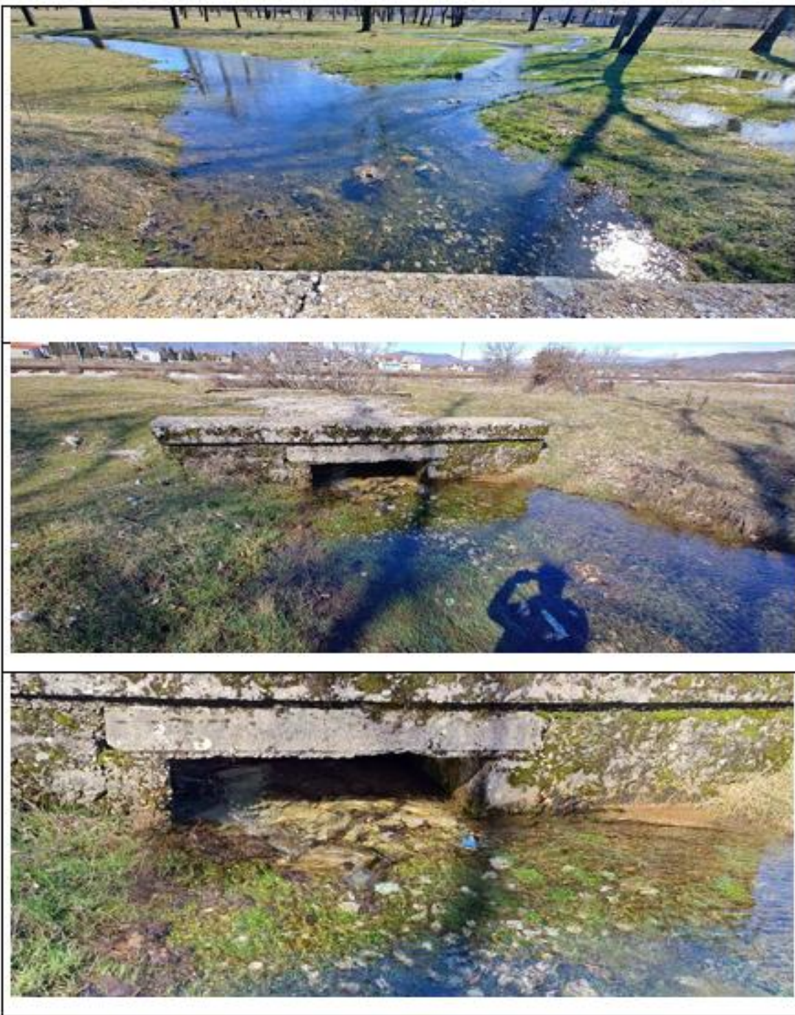
Sl. 2.13. Zona protoka 5 (zapadna strana-na malom mostu)
