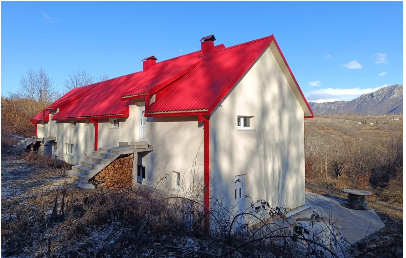
Slika 3: Pogled sa sjeverozapada
