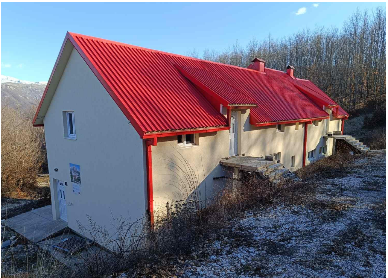
Slika 4: Pogled na objekat sa zapada
