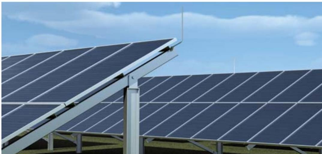
Sl. 3.4.12. Prikaz montaže loveće palice na metalnu konstrukciju
