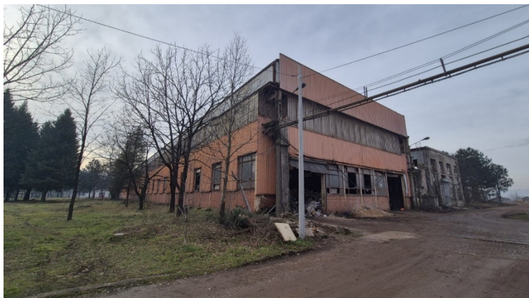
Slika 2.2. Izgled predmetnog objekta
