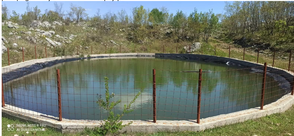
Slika -71 : Postojeća struktura za zahvat vode (bazen za zahvat)
