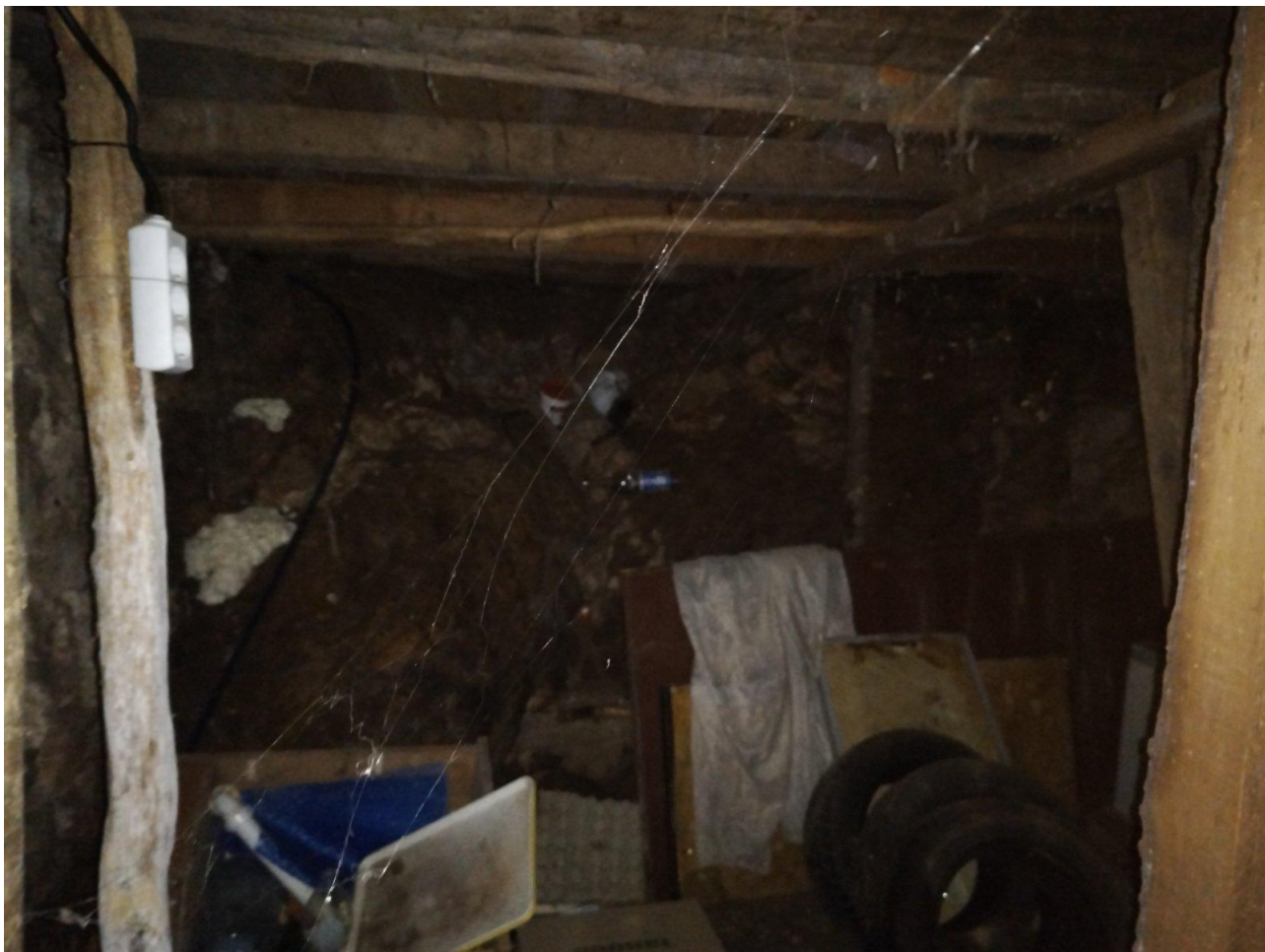
Slika 23: Pogled na zonu sjevernog zida koji je u dijelu suterena oslonjen na stijenu, koja je u dijelovima prekrivena zemljom
