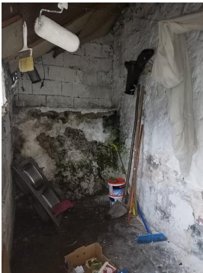
Slika 19: Nevješto dograđen i nedovoljno dobro zaštićen pretprostor na sjevernoj strani svijeta
