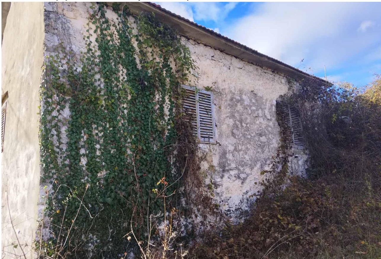
Slika 16: Detalj spoja južnog i istočnog zida . Oba su presvučena malterom a na istočnom raste bršljan
