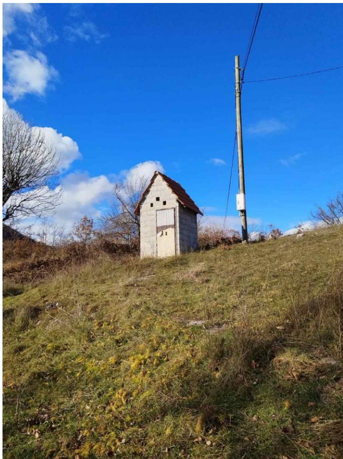
Slika 17: Pomoćni objekat –sušnica ,površine 2,88 m 2 ,koja je namijenjena za rušenje.
