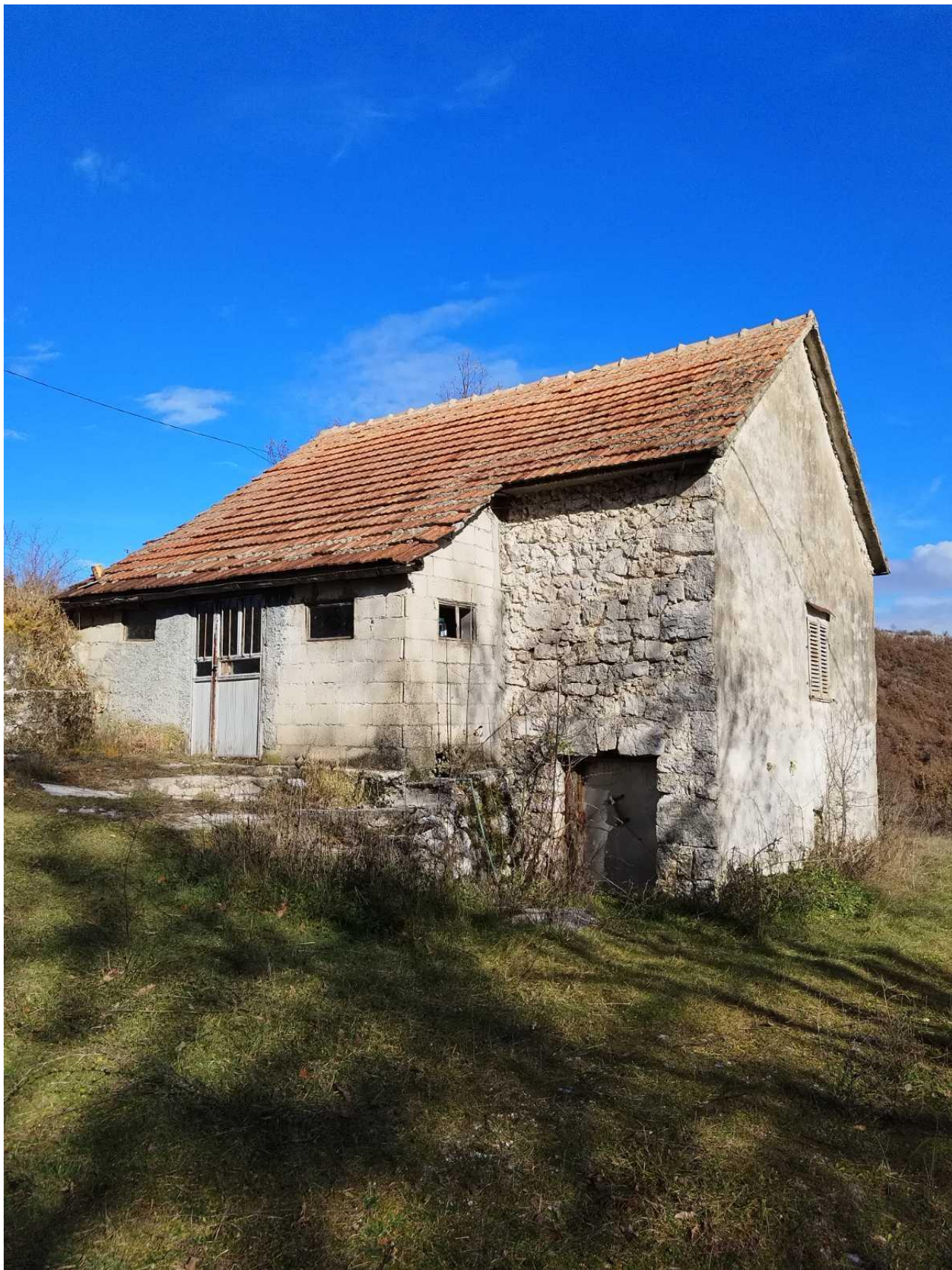
Slika 12: Pogled na stari kameni objekat sa jugozapada, koji je u zapadnom dijelu na mjestu ulaza dograđen betonskim blokom
