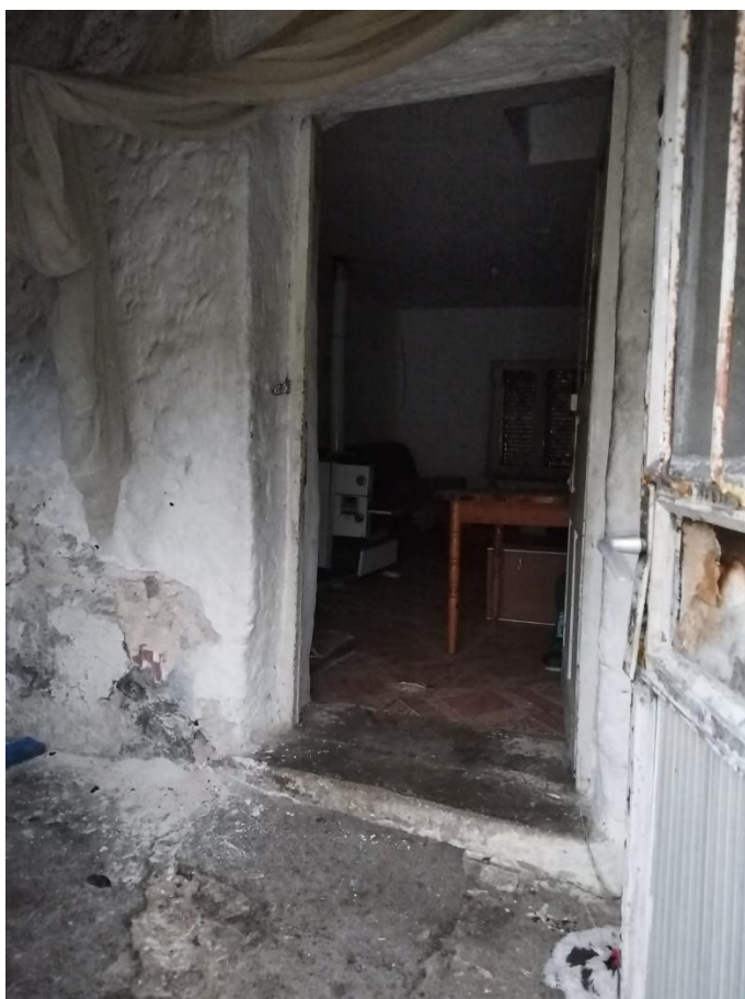
Slika 18: Zona dograđenog pretprostora iz kojeg se ulazi u dnevnu zonu, kamene kuće, koja je u enterijeru obložena krečnim malterom
