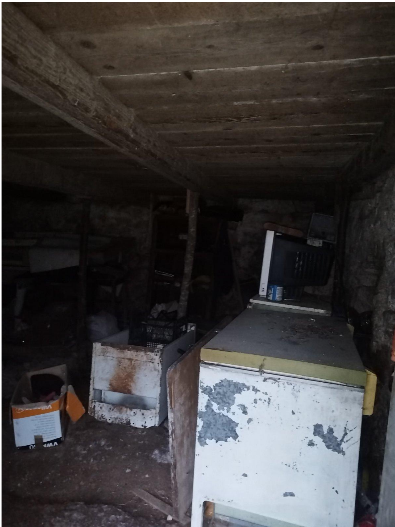
Slika 22: Zona ulaska u suteran sa pogledom na južni i istočni zid. Suteran nema projektovan pod, odnosno završni sloj je stijena i zemlja. Nekad je bio u funkciji izbe, kao prostor za čuvanje ovaca, dok je u trenutnom stanju skladište inventara i otpada
