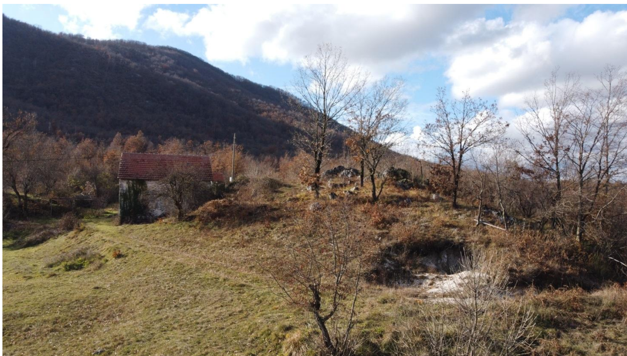
Slika 3: Pogled na objekat u ravni fasade sa istoka
