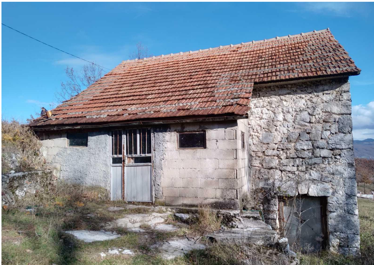
Slika 13: Pogled na zapadnu fasadu objekta
