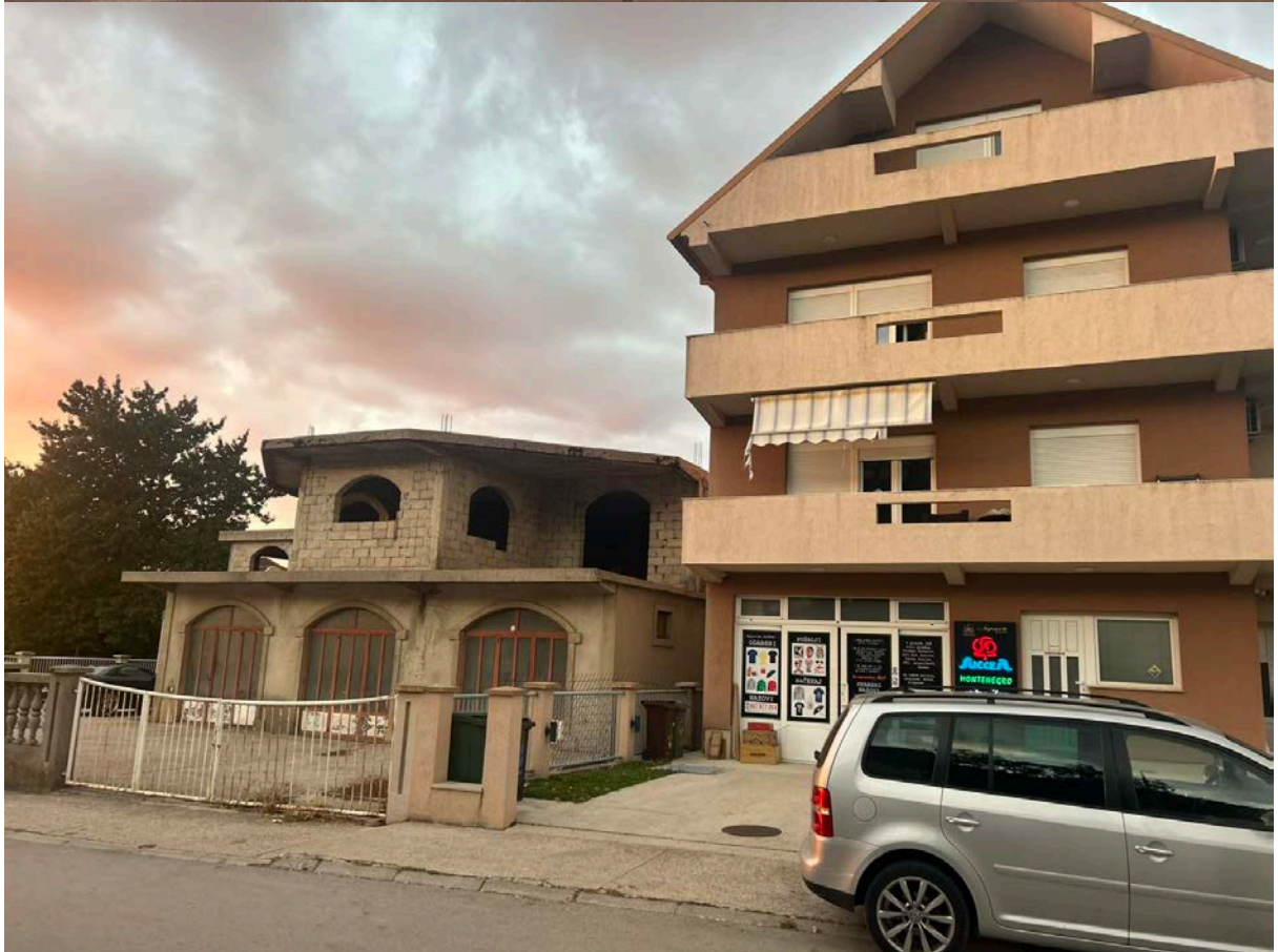
Prilog – foto lokacije i postojećeg objekta koji se nadgrađuje
